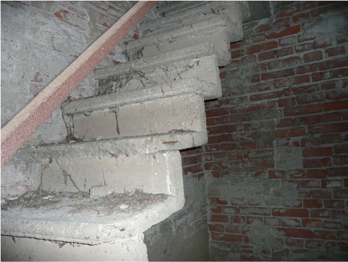
Fig. 2: vista dei gradini, in cui si nota che ogni elemento ad L appoggia sul precedente.
