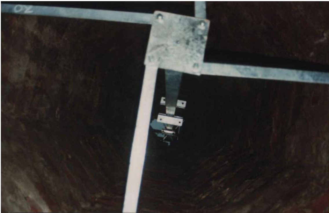
Fotografia del nuovo impianto campanario in fase di montaggio e fissaggio - 1994 [ fonte: privato ]
