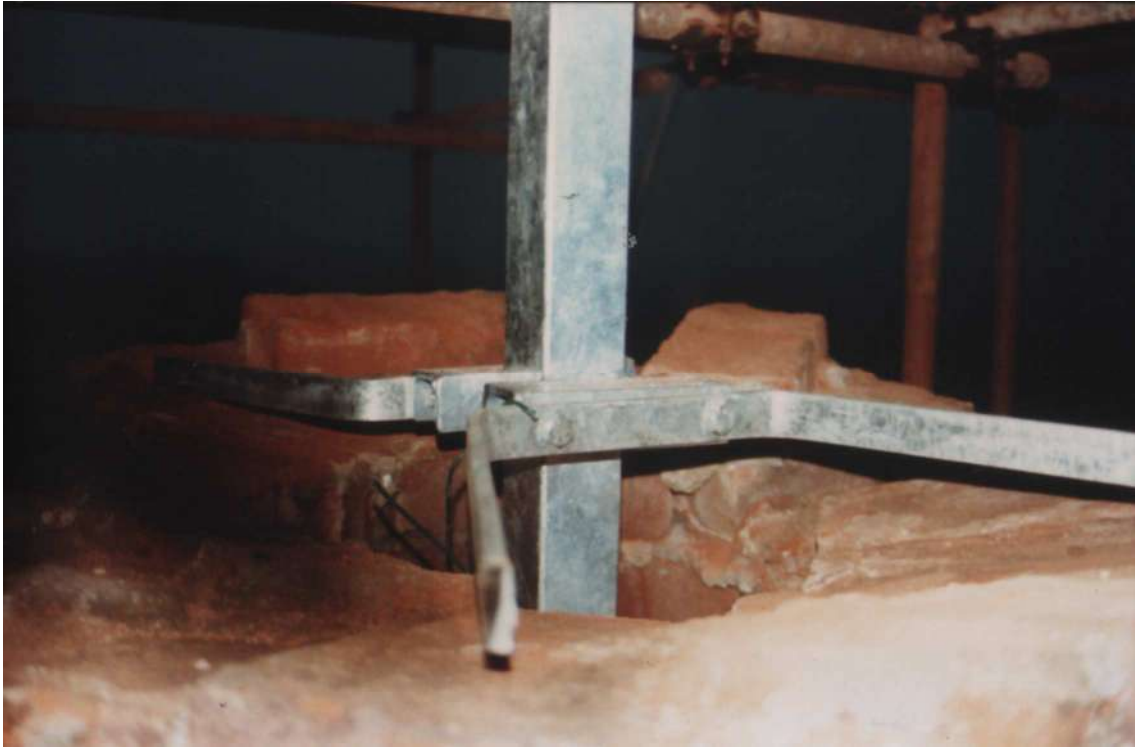
Fotografia del nuovo impianto campanario in fase di montaggio e fissaggio - 1994 [ fonte: privato ]
