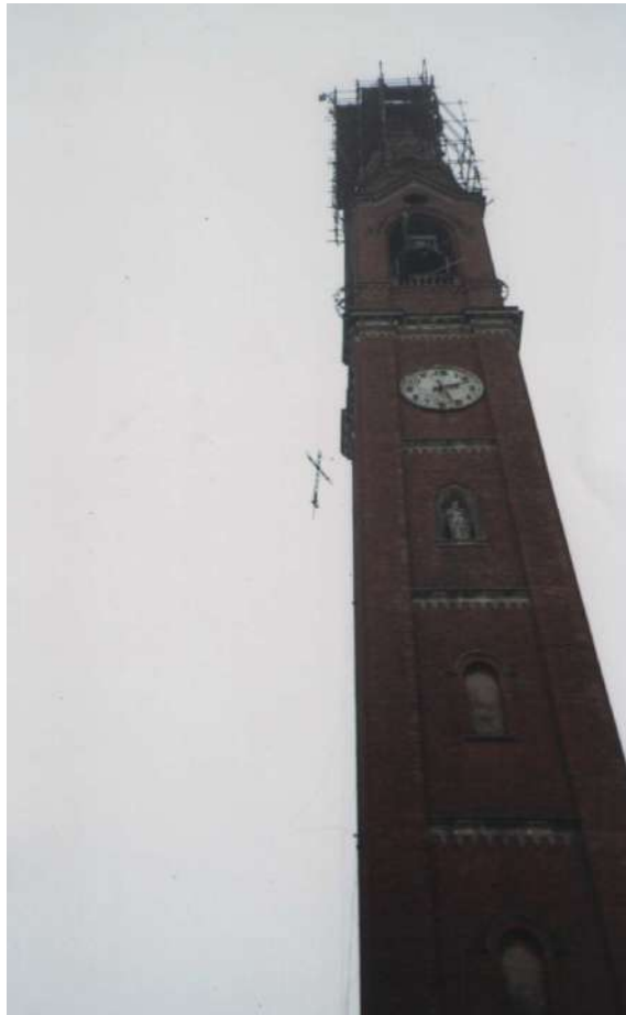
Fotografia smontaggio croce per restauro - 1994 [ fonte: privato ]
